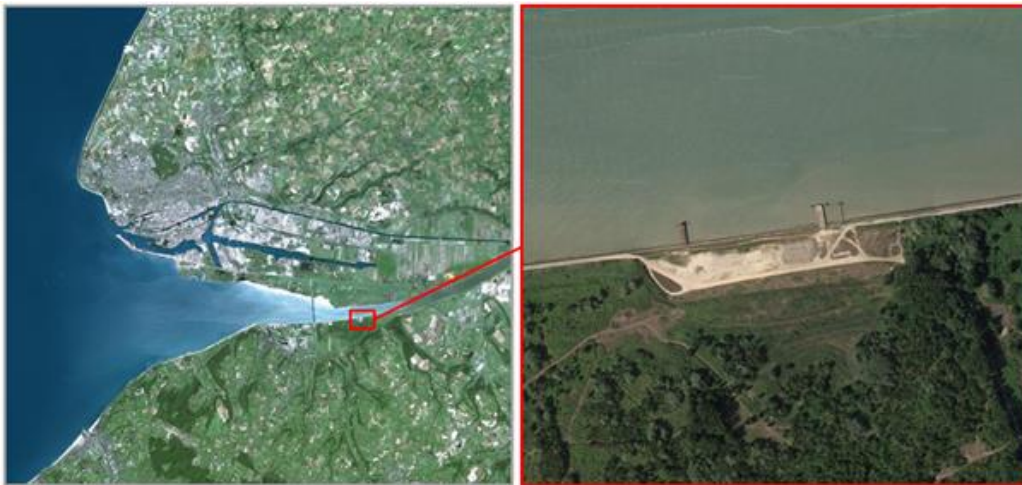
Figure 9 : Localisation du site de Fatouville. Sur la photographie de droite, le ponton considéré est la structure située juste en aval du marégraphe de Fatouville (Levallois, 2020).
