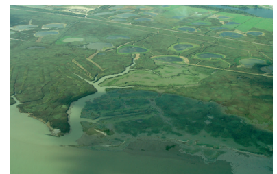
➔ Filandres et gabions à l'embouchure de la Seine
